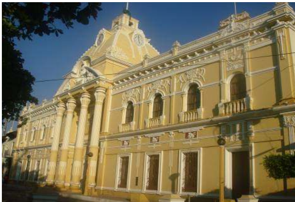
Fotografía No. 4: Palacio de Gobernación de Retalhuleu. Fuente: SEGEPLAN, 2010.
