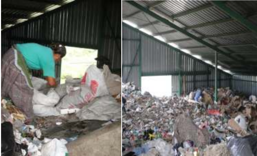
Fotografías Nos. 8 y 9. Planta de tratamiento de desechos sólidos. Fuente: SEGEPLAN, 2010.
