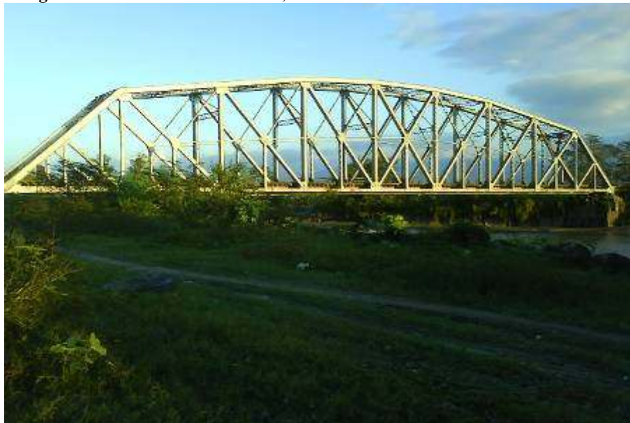
Fotografía No. 7. Puente de Oncida, Morales.
