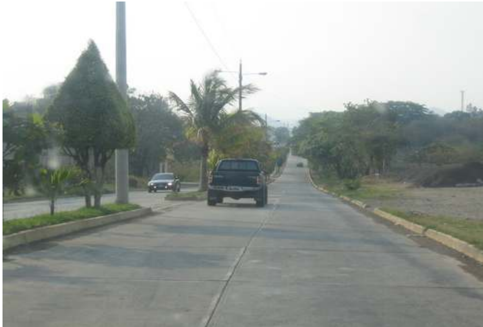
Fotografía No. 4. Calzada El Progreso. Fuente: 2010.
