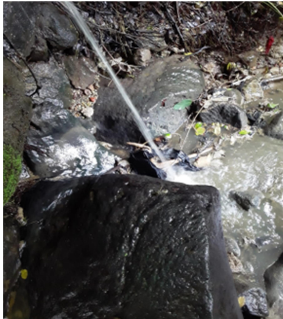
Figura 2. Desfogue de aguas residuales, pozo de Don León, Aldea San Juan Tapalapa, Casillas, Santa Rosa
