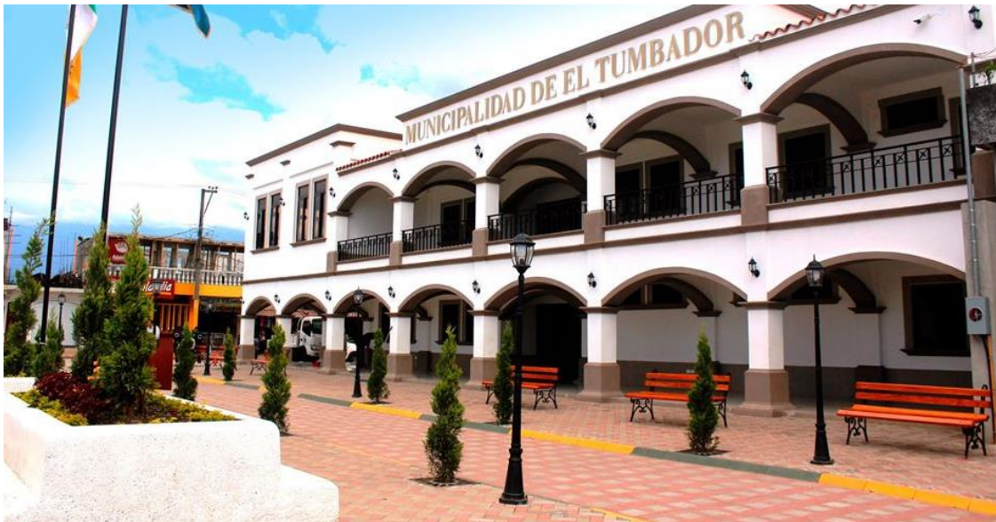
Edificio municipal de El Tumbador, San Marcos. Fuente: Municipalidad de El Tumbador, San Marcos.
