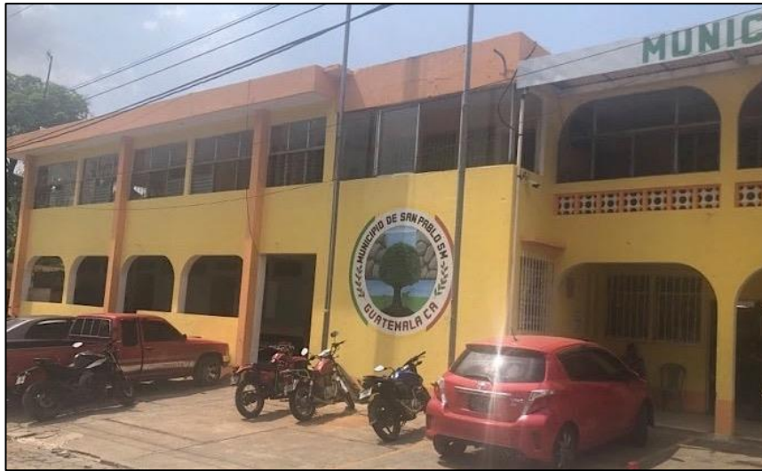
Edificio municipal de San Pablo
