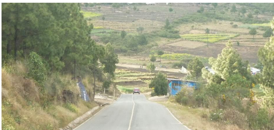
Fotografía 2. Vista carretera asfaltada, en regulares condiciones.
