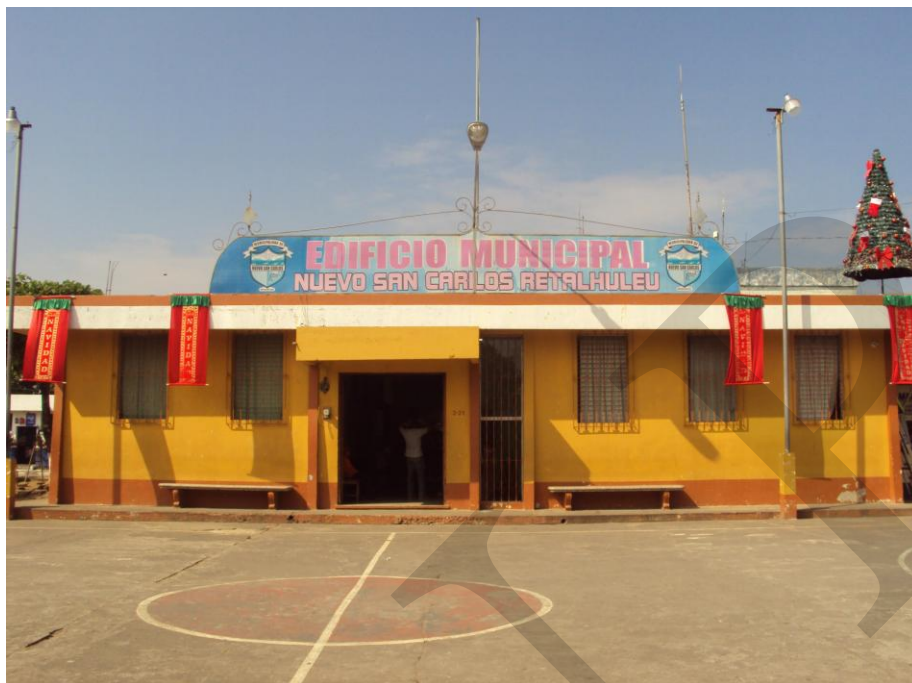
PALACIO MUNICIPAL NUEVO SAN CARLOS
