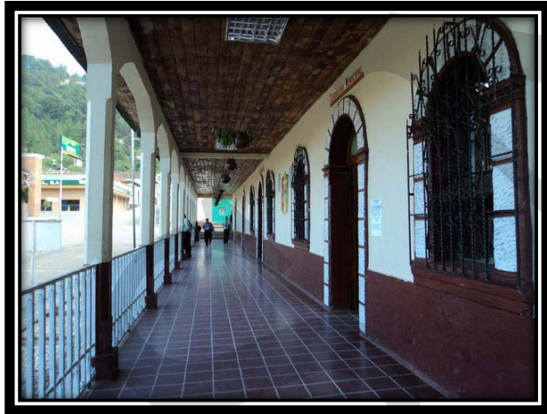
Pasillo del edificio municipal
