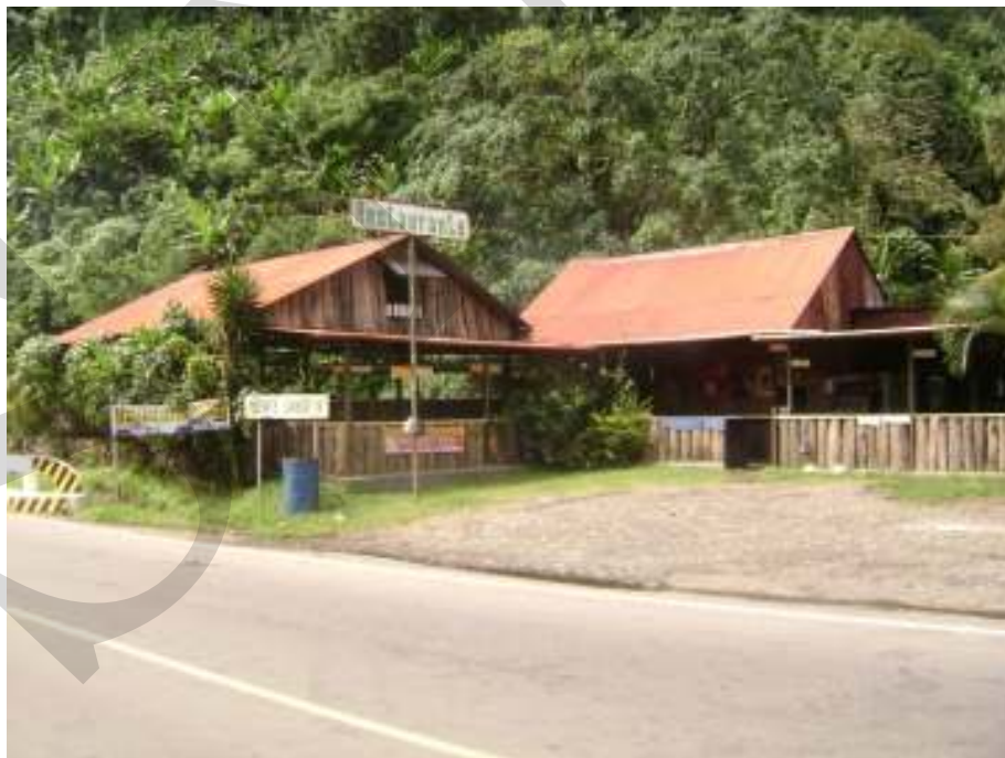
Foto 6. Entrada a un centro recreativo privado denominado Nuevo San Rafael
