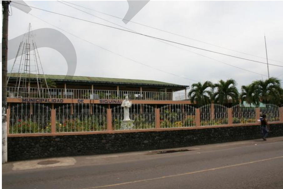
Figura No. 9 Municipalidad de Siquinalá. Fuente: Informe final de Tesis de Walter Aguilar, Facultad de Arquitectura-USAC, 2009.
