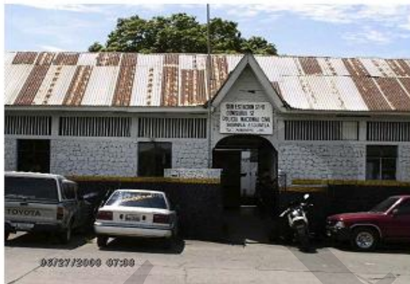
Figura No.3. Sub-estación de PNC ubicada en el área central del Municipio. Fuente: Informe final de Tesis de Eddy Ramírez, Facultad de Humanidades-USAC, 2009.
