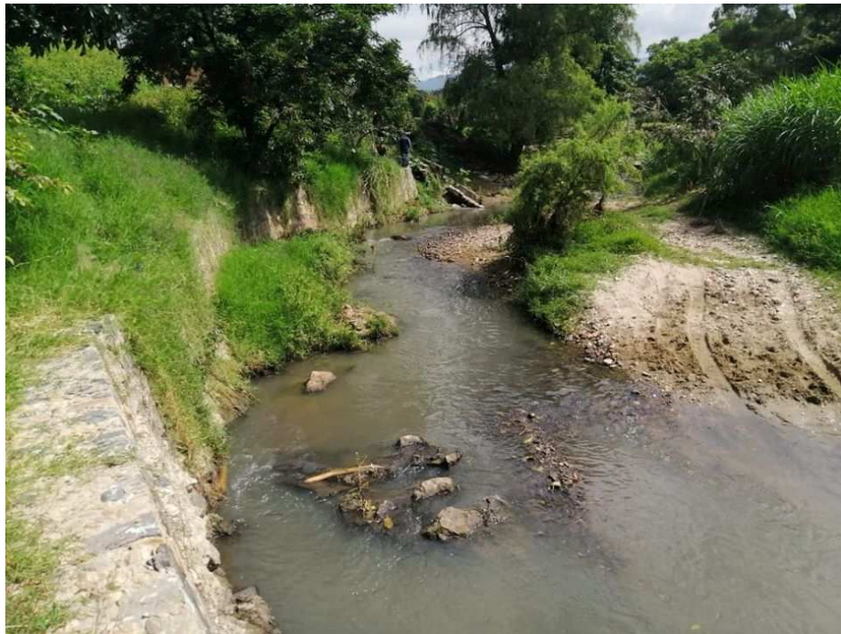
Fotografía No. 02 Desfogue de aguas residuales, en Río Rabinal, final 7av Zona 2, Rabinal, Baja Verapaz 2019
