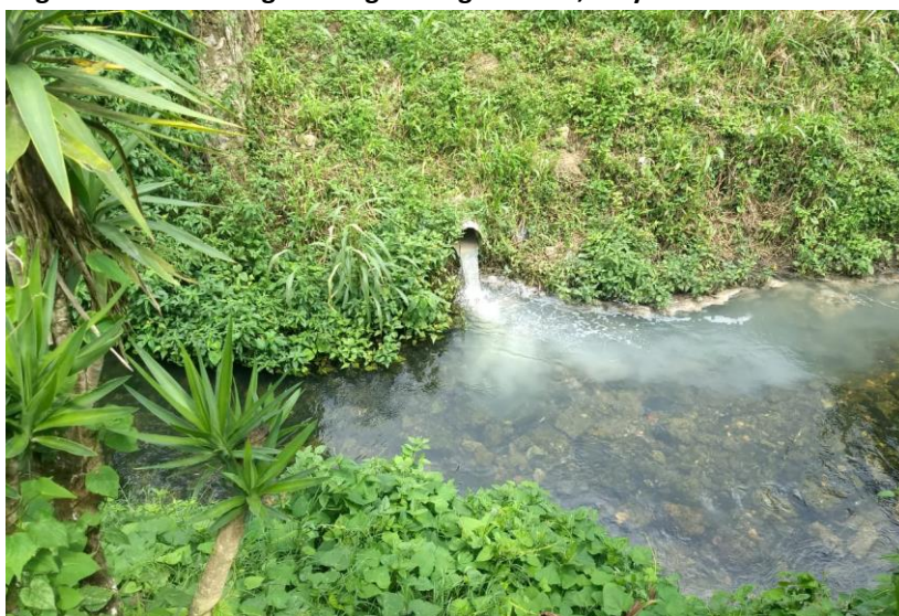
Fotografía No. 1. Desfogue de aguas negras al río, Fray Bartolomé de las Casas
