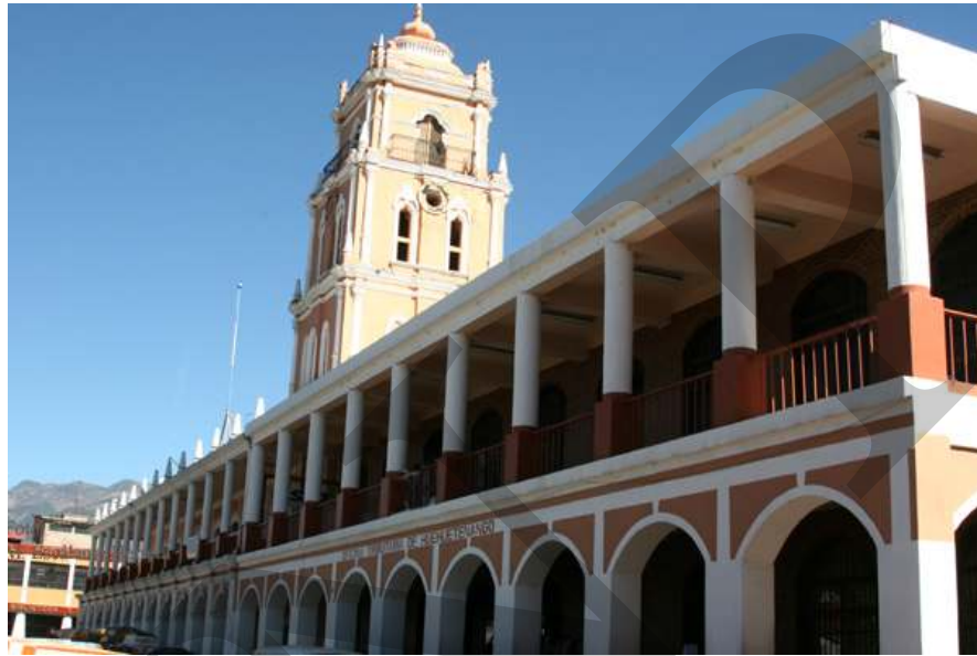
Edificio de Gobernación Departamental
