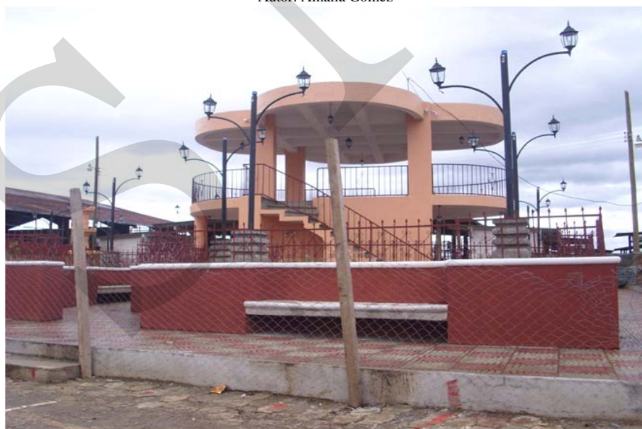
Foto 4. Parque Central en construcción. Autora: Amalia Gómez
