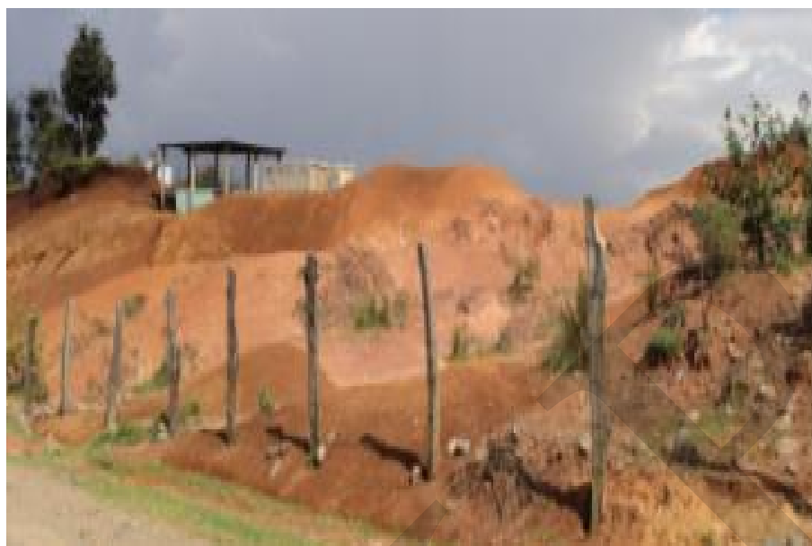
Figura No. 2 Erosión del suelo.
