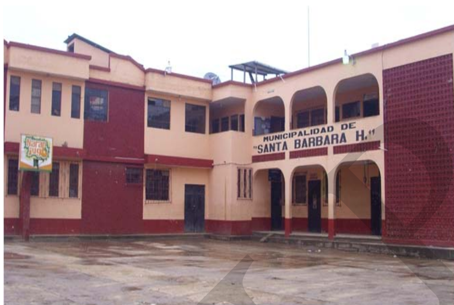
Foto 3. Edificio municipal. Autora: Amalia Gómez.
