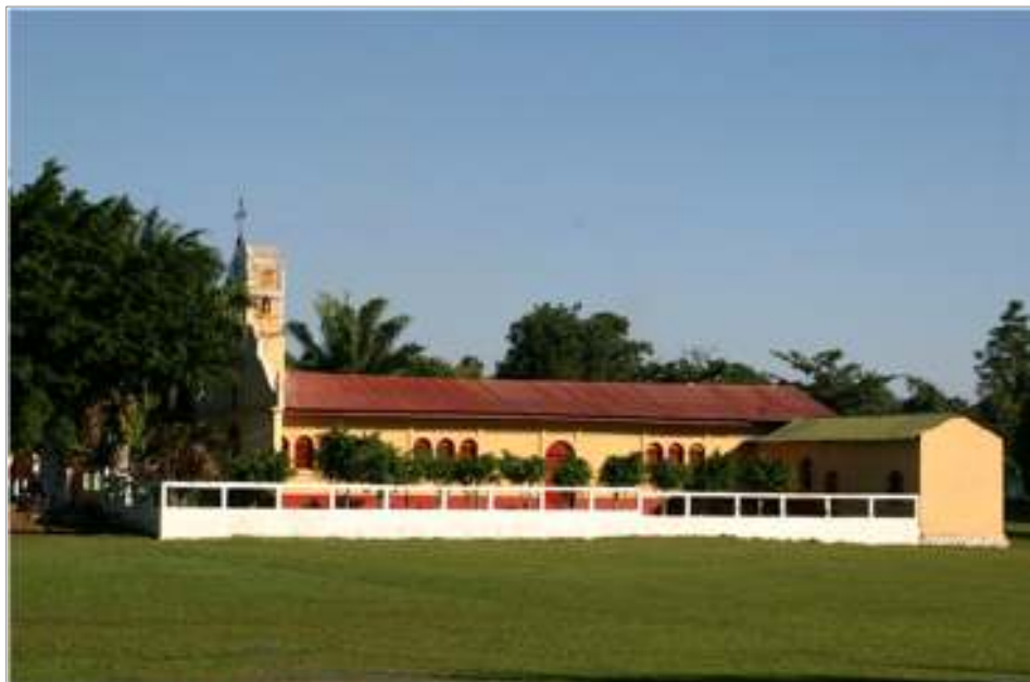
Figura No. 7 Vista panorámica de la Iglesia
