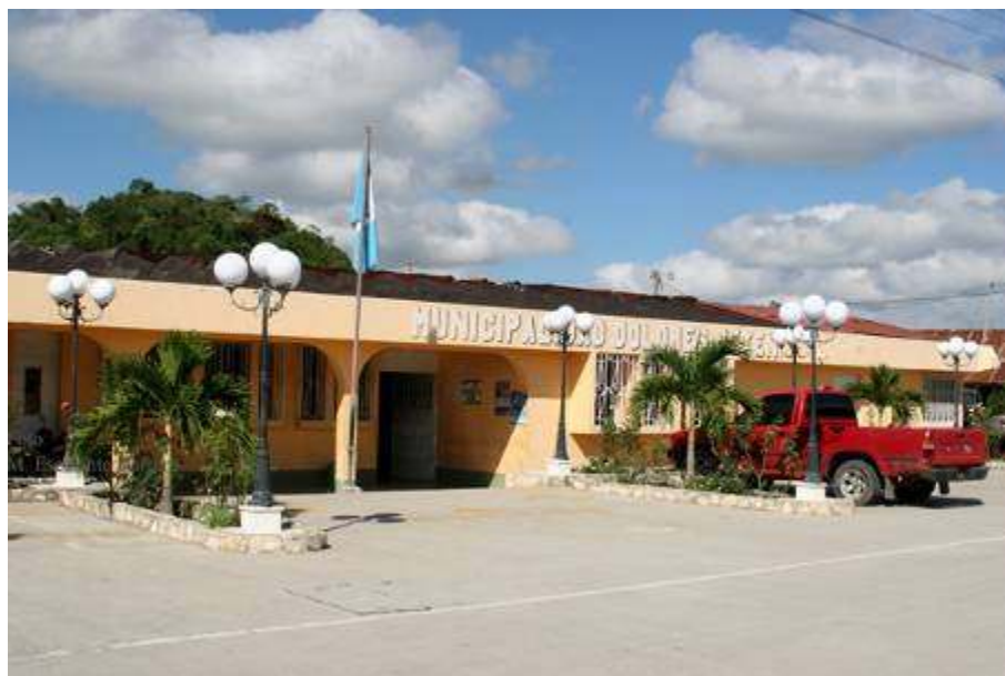
Figura No. 7 Edificio municipal de Dolores, Petén
