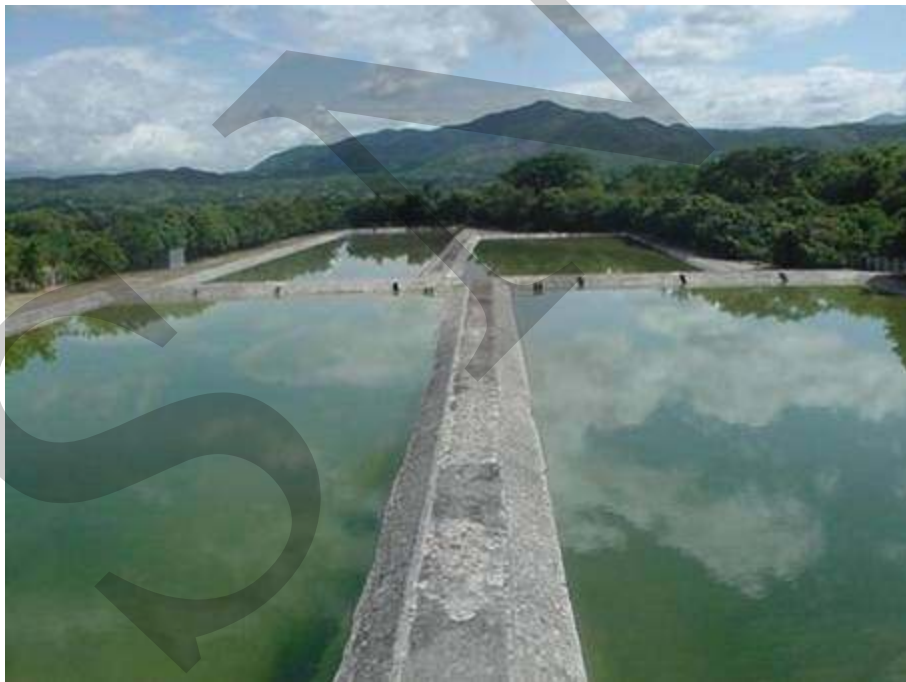
Figura No. 4 Fotografía planta de tratamiento de aguas servidas, Estanzuela 2010. Fuente: DMP, 2010.
