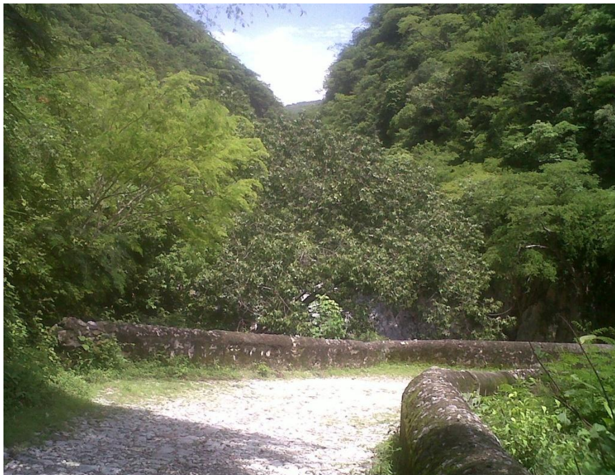
Fotografía No. 4. Ingreso Puente La Barranquilla. Fuente: Wendy Véliz; 2012.
