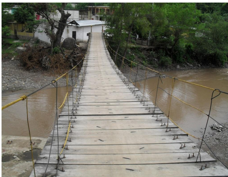
Fotografía No. 2. Puente colgante Sinaca. Fuente: Wendy Véliz; 2012.
