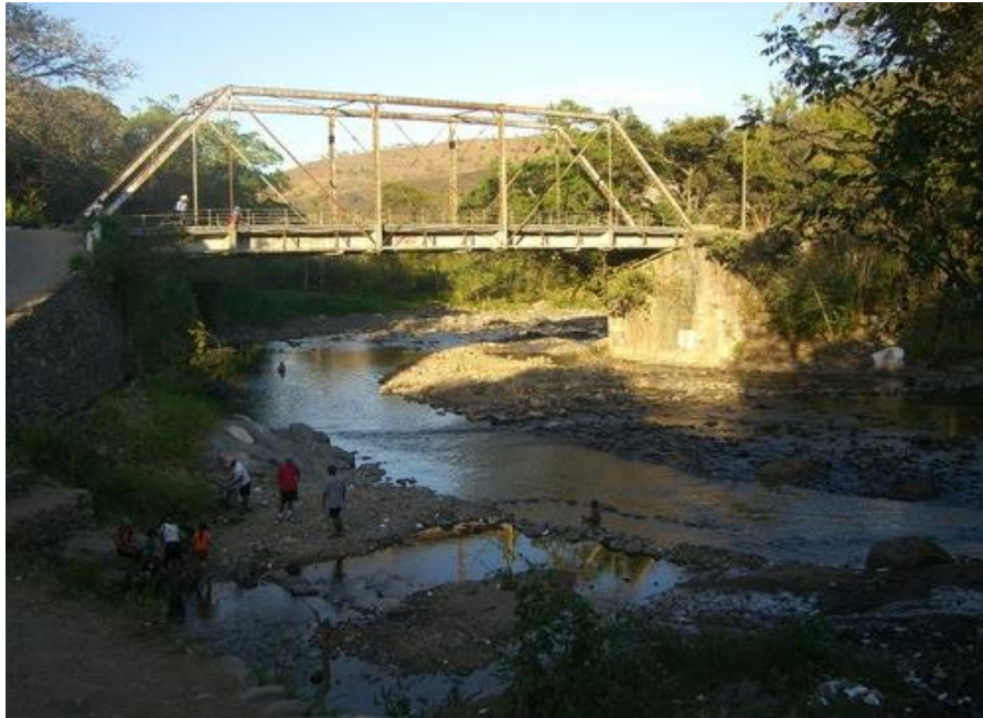
Fotografía No. 3. Puente Los Plátanos. Fuente: Municipalidad de Sanarate; 2012.
