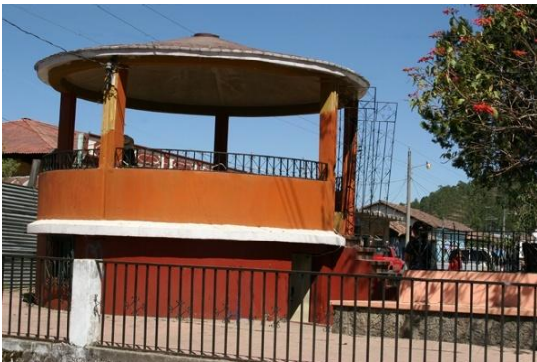
Kiosco ubicado en el parque municipal de San Bartolo, Aguas Calientes
