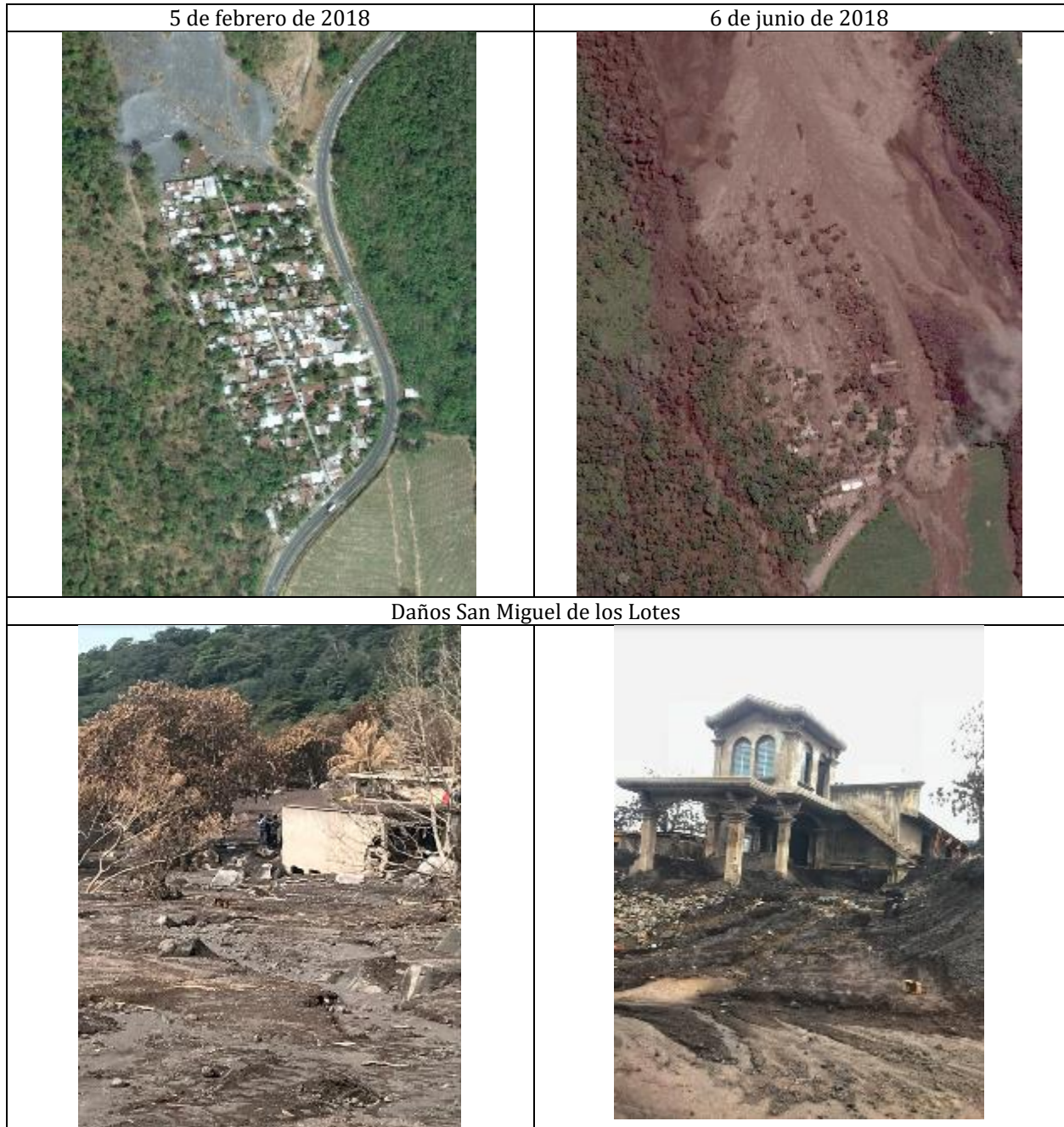
Imagen 2. Afectaciones comunidad de San Miguel de Los Lotes
