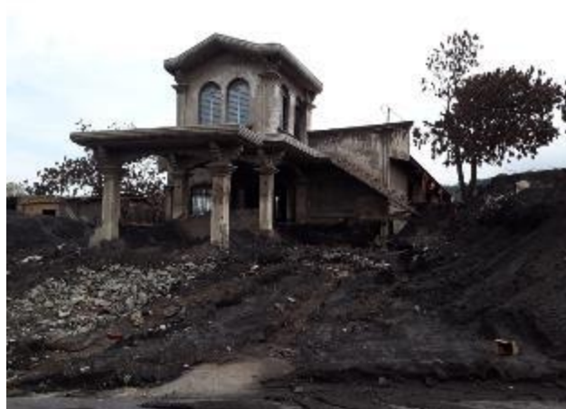
Tipología constructiva San Miguel Los Lotes Fuente equipo evaluador
