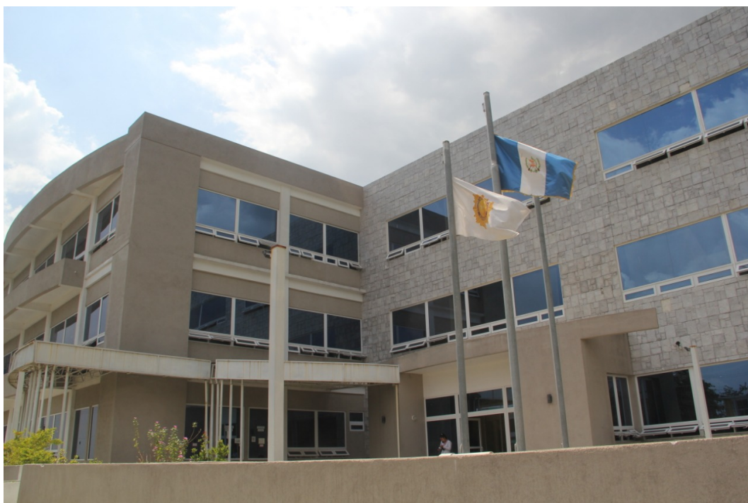
Edificio de Policía Nacional Civil, Comisaria 34, Departamento de Retalhuleu
