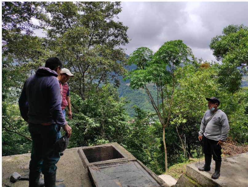
Fotografía 4 de riesgo en tanque de almacenamiento
