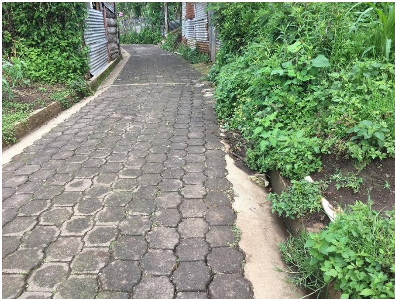
Fotografía 8 Riesgo tubería de distribución 2
