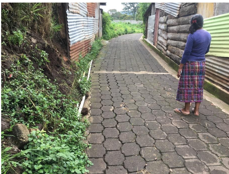
Fotografía 7: Fotografía de riesgo tubería de distribución
