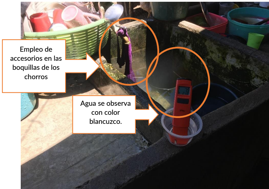
Fotografía 10 Fotografía de riesgo puntos de consumo 2
