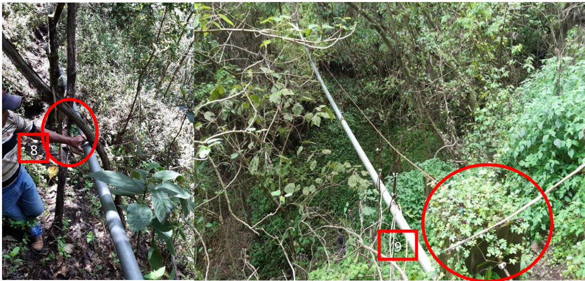
Fotografía 4. Tubería de línea de conducción
