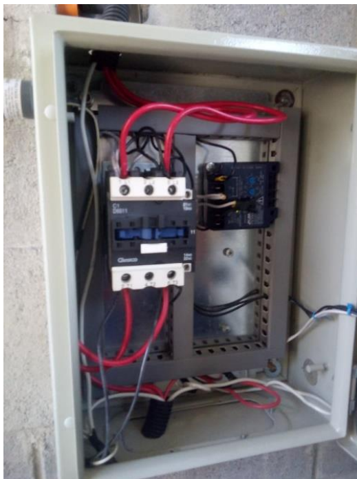
Fotografía 5. Timer y contactor. Elaboración propia.
