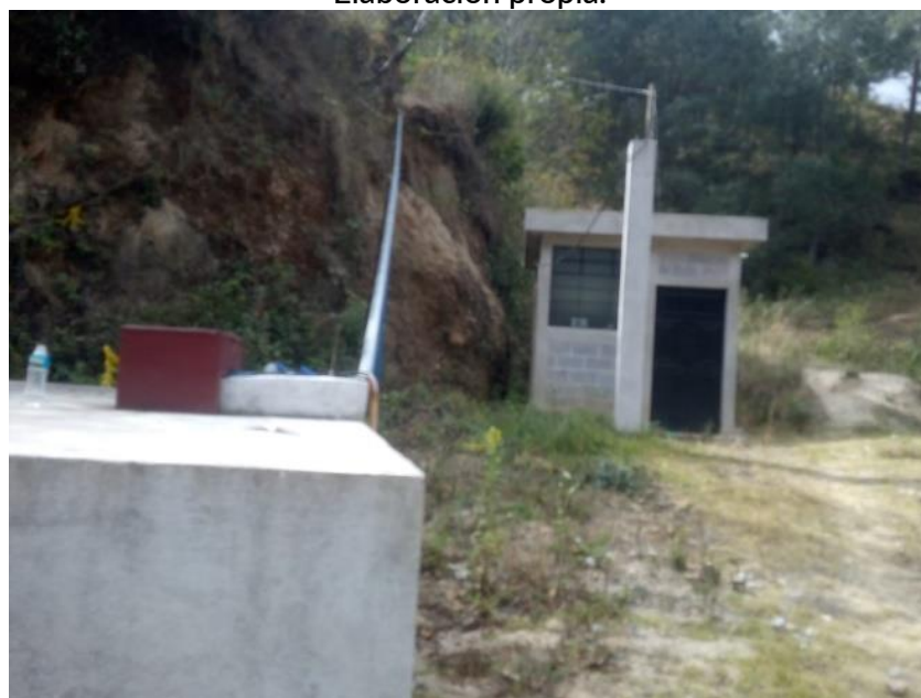
Fotografía 3. Tanque de captación y caseta de bombeo. Elaboración propia.
