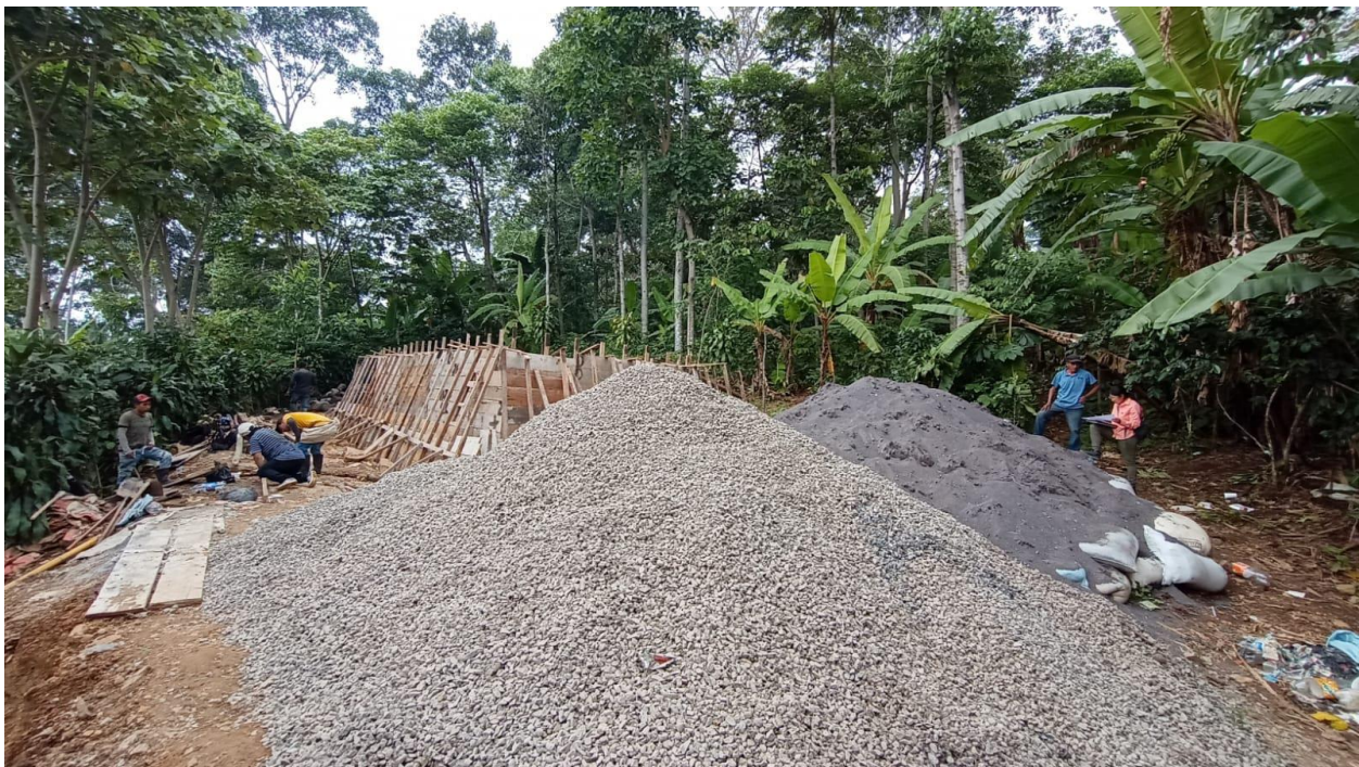
Fotografía 4. Tanque de distribución existente, se prevé la construcción de espacio físico para sistema de desinfección.
