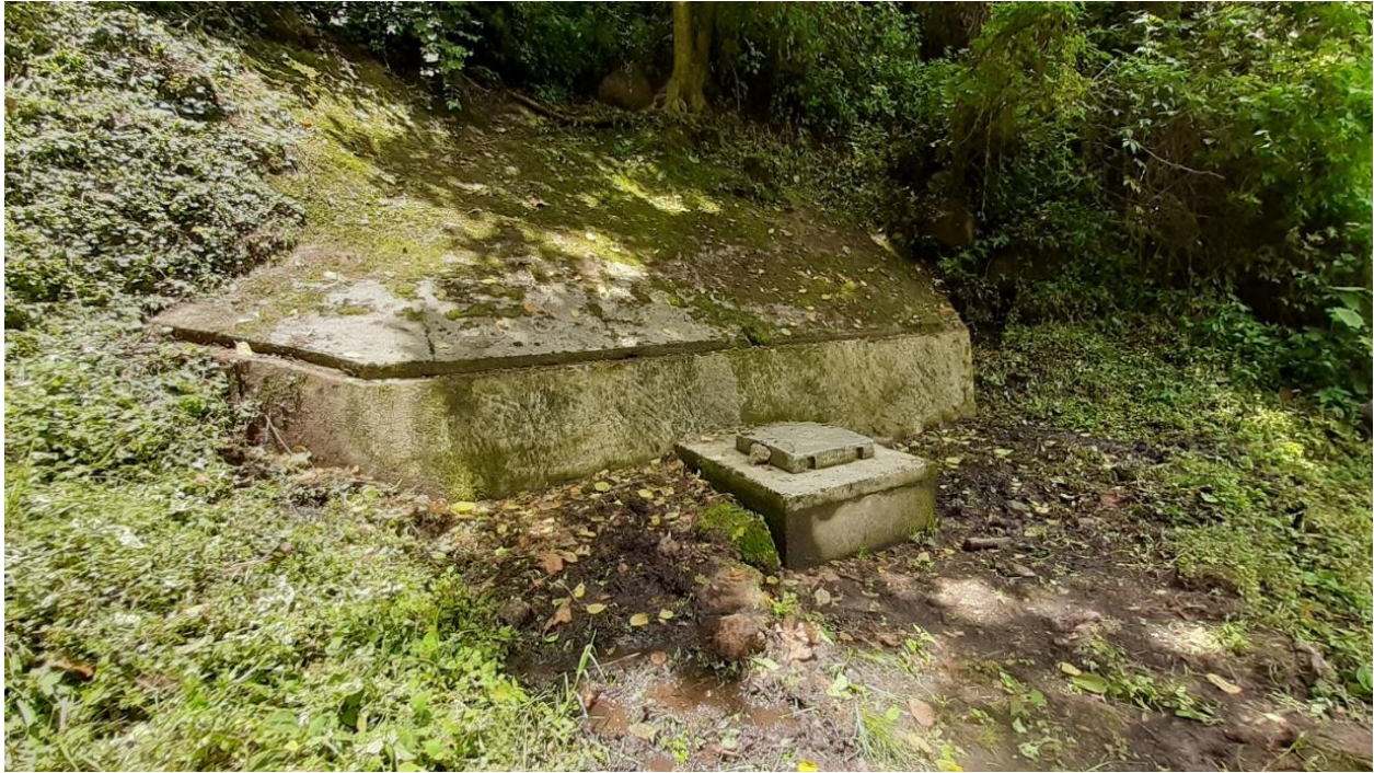
Ilustración 4: Fotografía de riego en la captación No. 1
