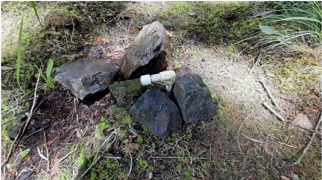
Ilustración 6: Fotografía del estado actual de las válvulas de aire
