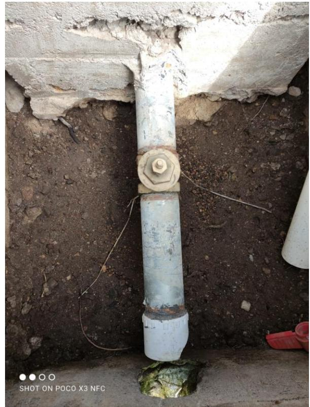
Ilustración 6: Fotografía de válvula de aire y la falta de la válvula de limpieza en la línea de conducción
