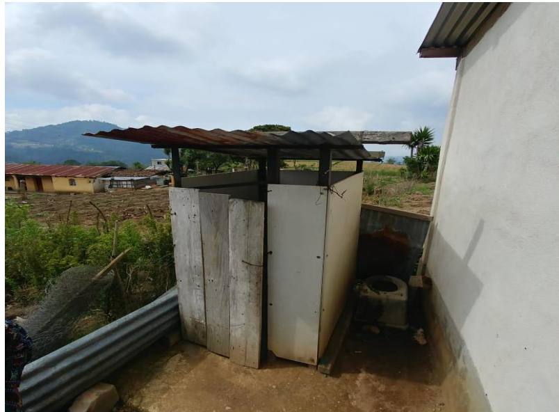
Ilustración 8. Letrinas de hoyo seco en Caserío El Progreso, Aldea Pujujil I
