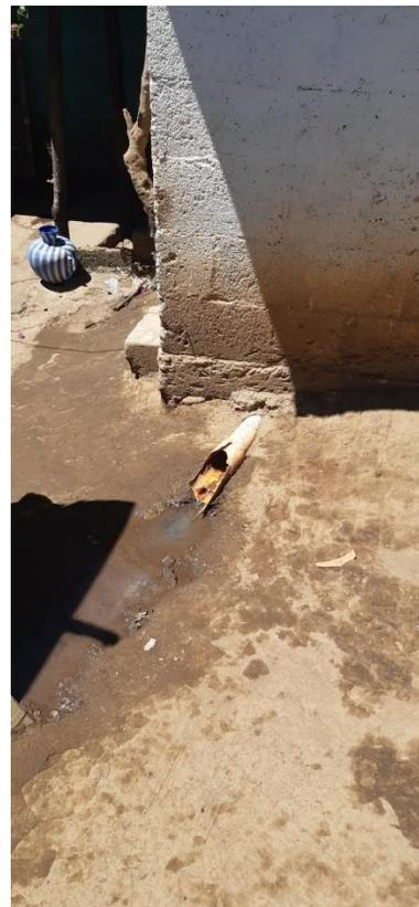
Figura 7 Tuberías expuestas dentro de vivienda
