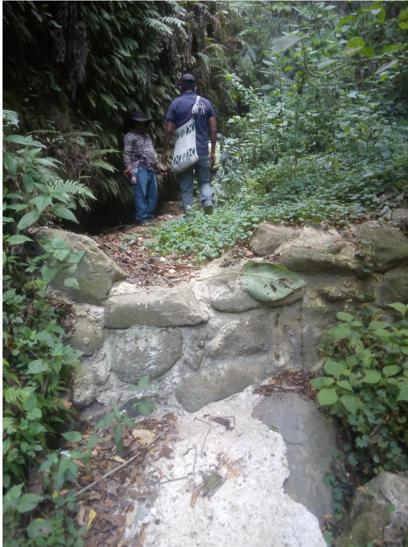
Fotografía 1. Captación Elaboración propia.
