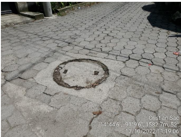
Fotografía 14 Pozo de visita sistema de alcantarillado sanitario
