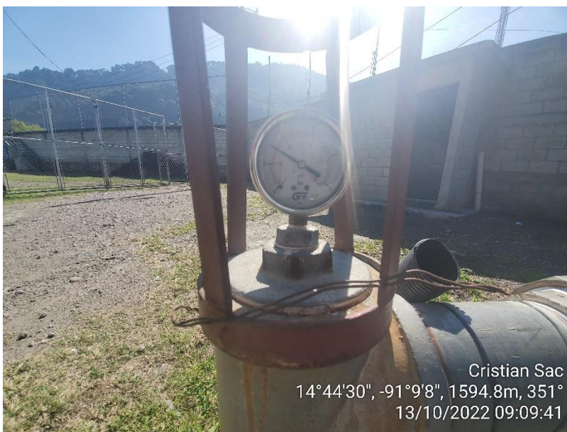
Fotografía 3 Manómetro pozo mecánico
