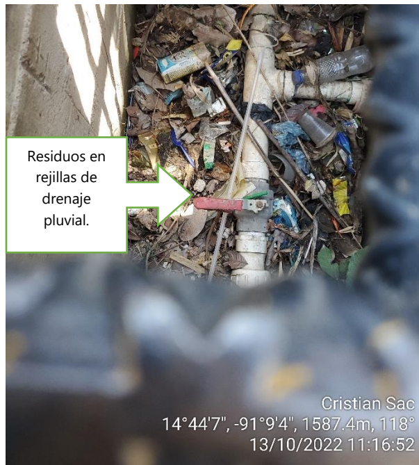
Fotografía 13 Riesgo agua contaminada en válvulas 2
