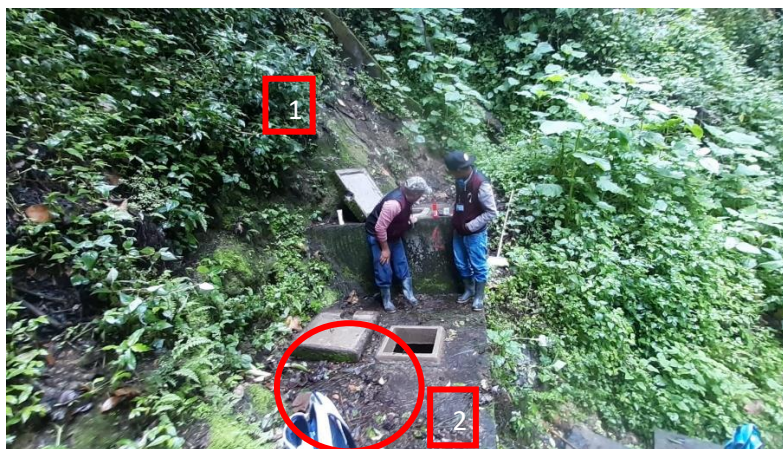
Fotografía 1 Evaluación de riesgos de captación de fuente de agua
