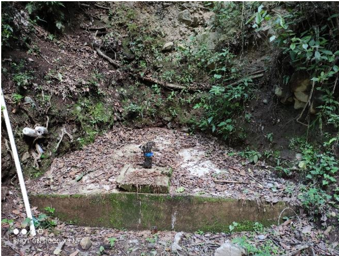
Ilustración 3: Fotografía de riesgo en la captación
