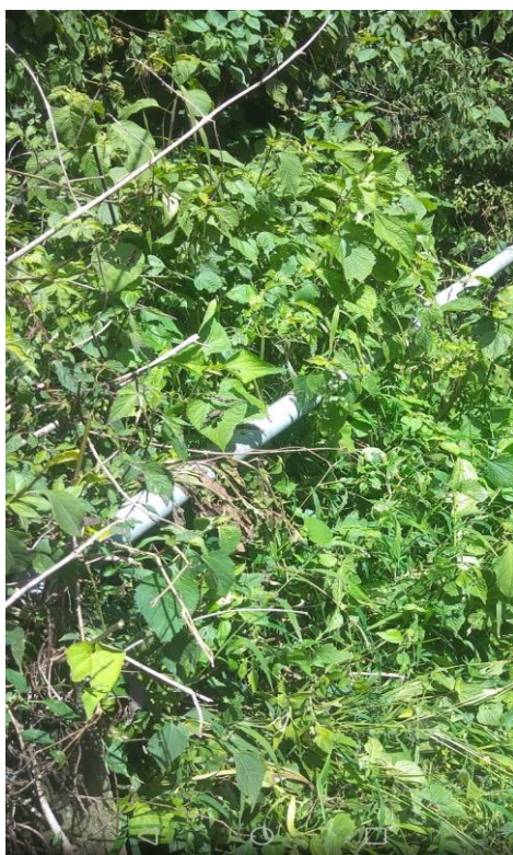
Figura 5 Paso aéreo del sistema
