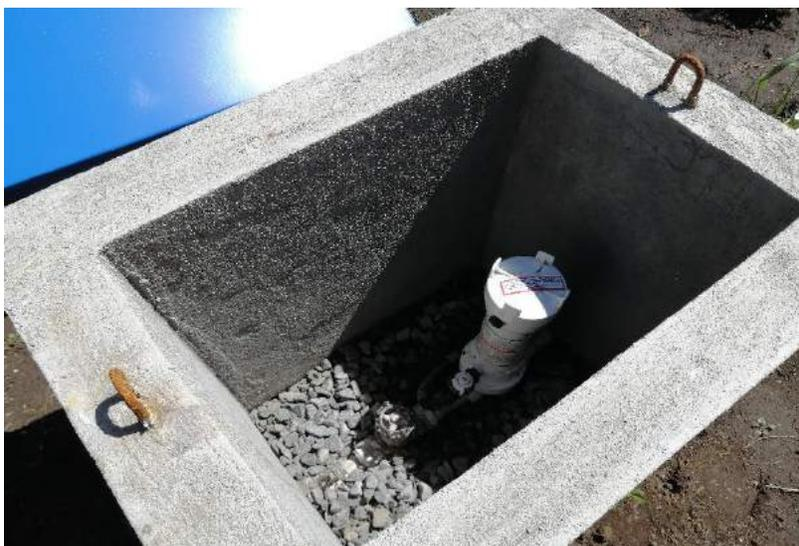
Fotografía 7 Clorador, termo de desinfección por erosión de pastillas
