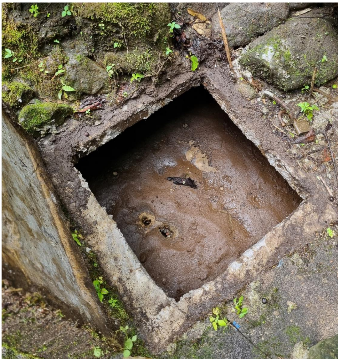
Fotografía 2. Riesgo de contaminación por sello sanitario en tapadera de captación deficiente. Elaboración propia.
