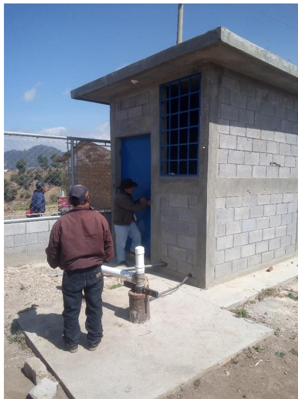
Fotografía 1. Caseta de bombeo Elaboración propia.
