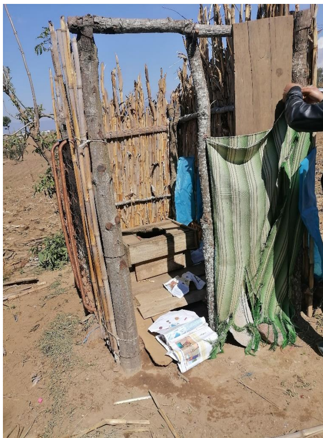
Fotografía 4. Letrinas Elaboración propia.
