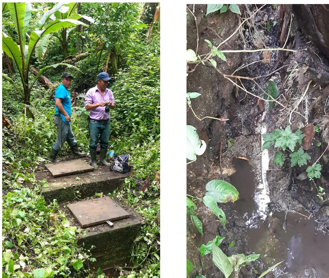
Figura 3 Captación del sistema
