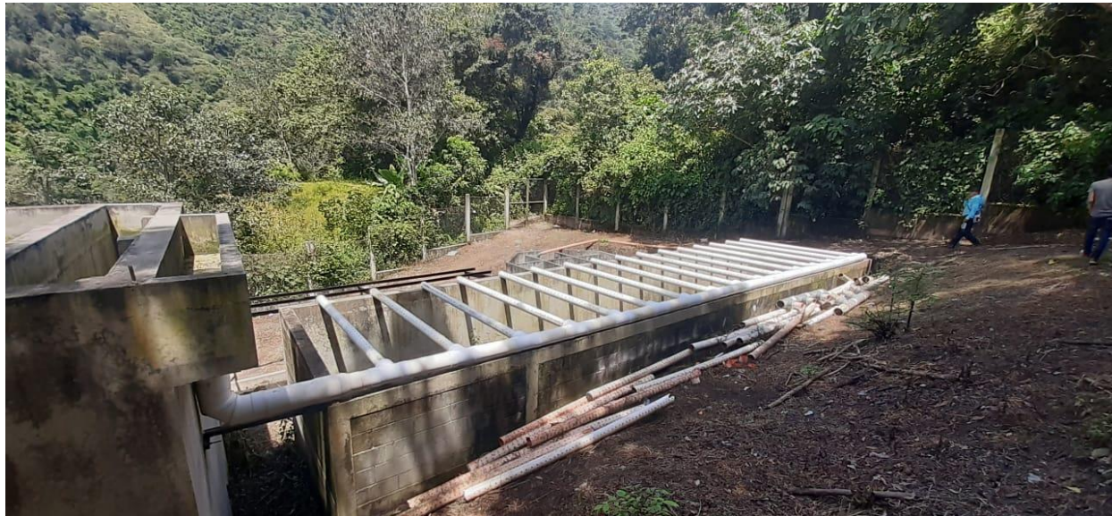
Figura 7 Planta de tratamiento de aguas residuales
