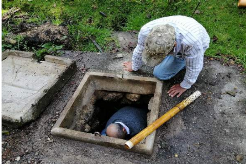
Fotografía 2 Caja de captación de nacimiento Puwal Chalip 2
