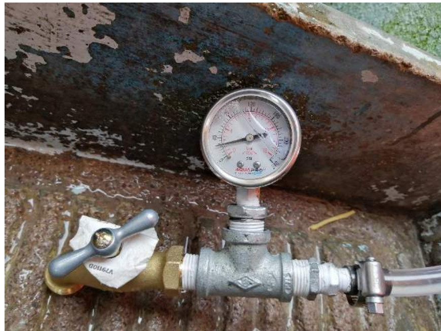
Fotografía 8 Medición de presión en chorros domiciliarios
