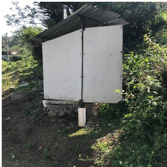
Ilustración 6. Se representa la disposición final de excretas, mediante letrinas de hoyo seco ventilado.
