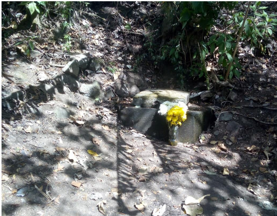
Fotografía 1. Captación de nacimiento por gravedad Elaboración propia.
