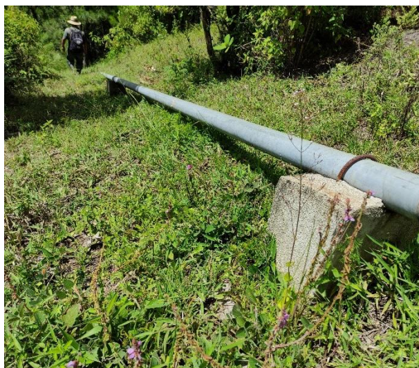
Ilustración 12: Fotografía de tubería con anclajes
