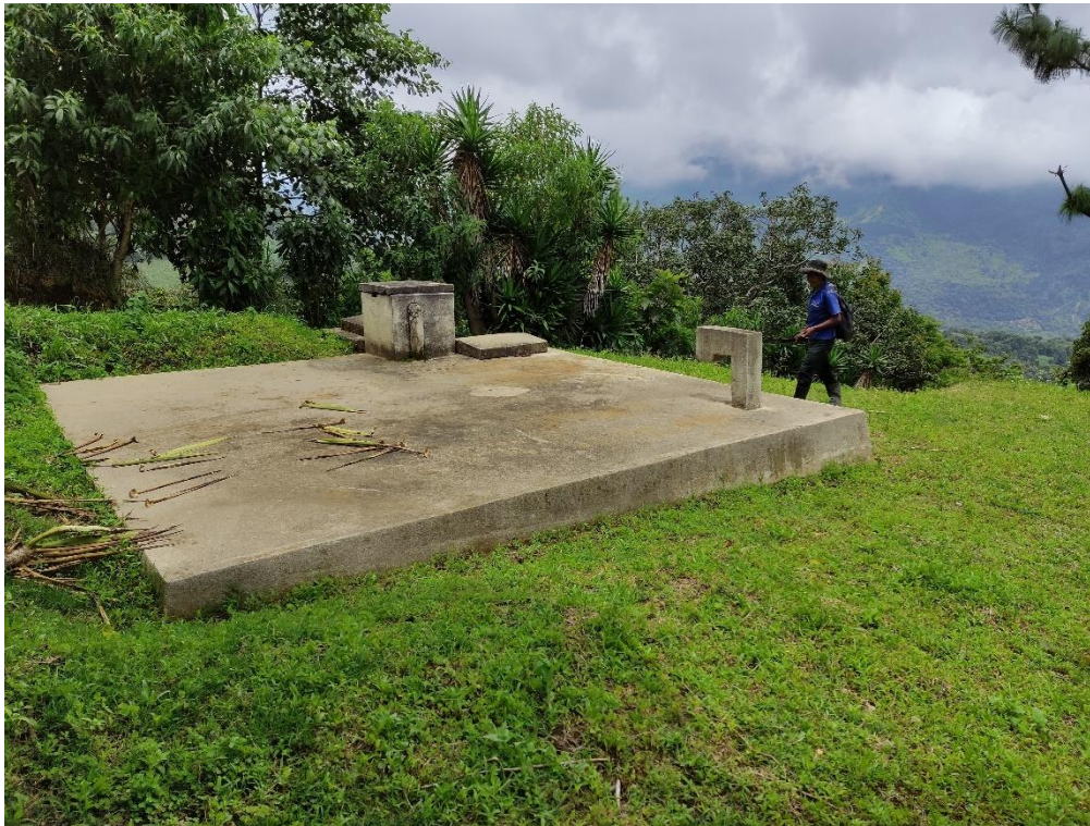
Ilustración 13: Fotografía del tanque de distribución
