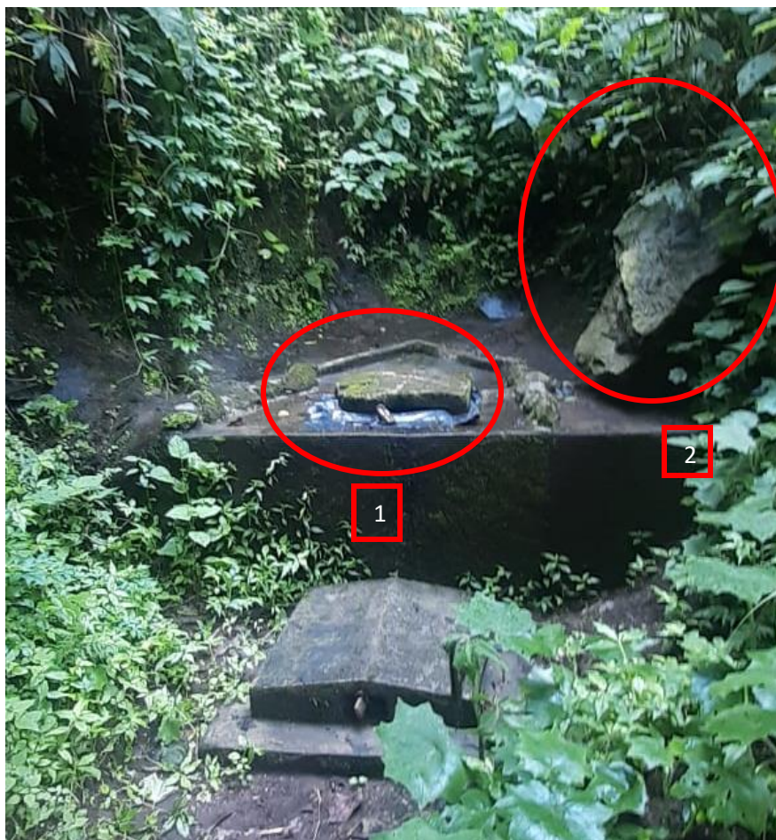
Fotografía 1. Evaluación de riesgos de captación de la fuente de agua
