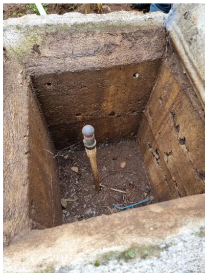
Fotografía 5. Tubería expuesta de línea de conducción.
