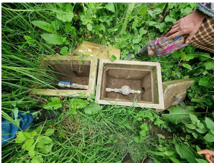
Fuente: Visita técnica 25/08/2021
