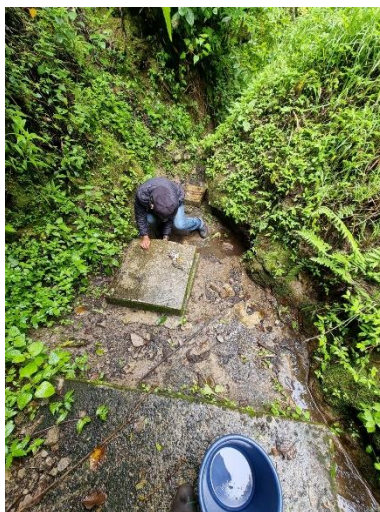
Fuente: Visita técnica 25/08/2021
