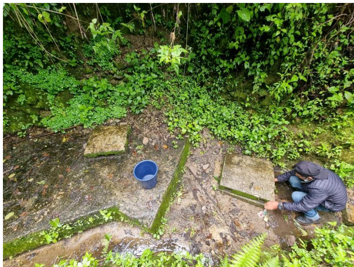
Fuente: Visita técnica 25/08/2021
