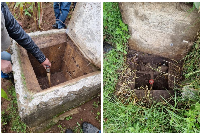
Fotografía 12. Válvula de aire y de limpieza.
