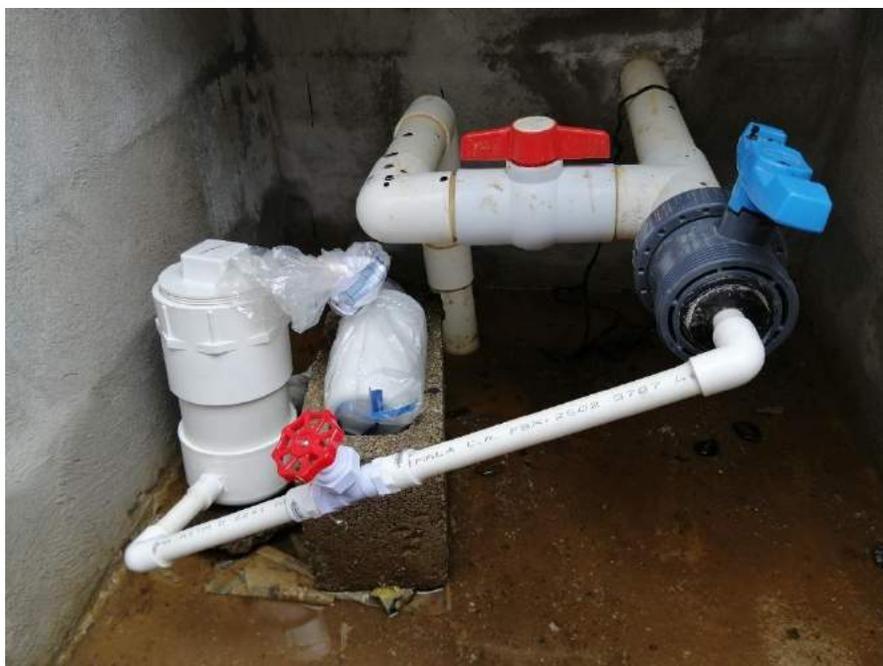
*Fotografía 7 Sistema de desinfección, más instalación de clorador artesanal sobre el tanque de distribución.*
