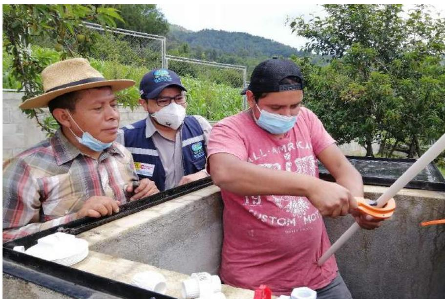
*Fotografía 8 Instalación del clorador artesanal*
