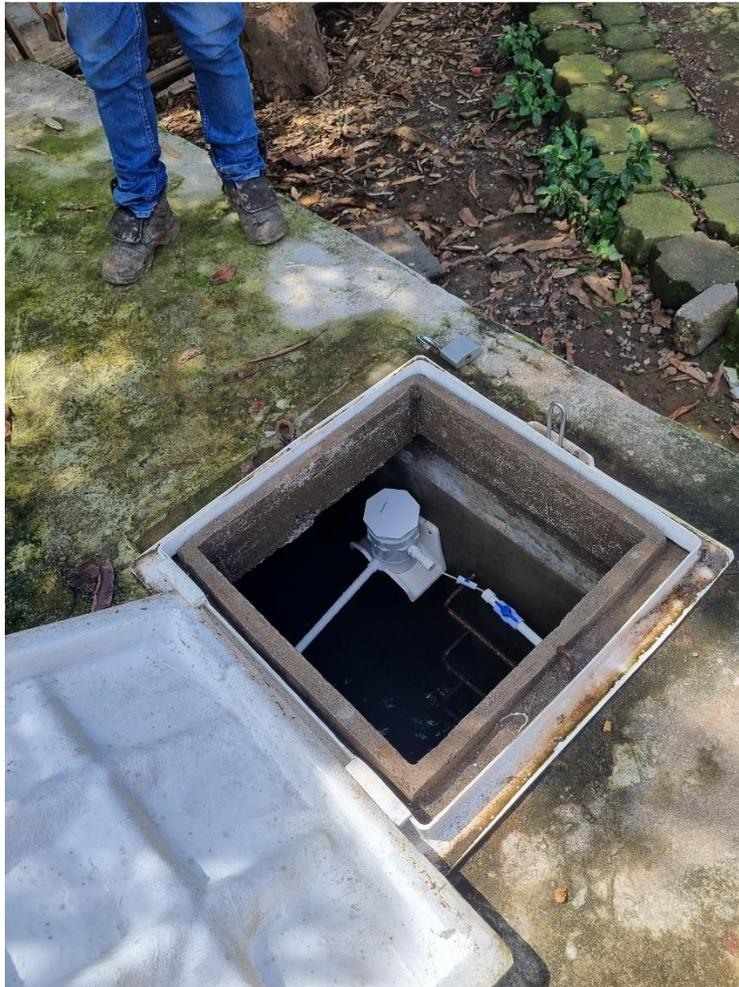
Fotografía 5. Existe un sistema de desinfección, pero aún no se ha conseguido una dosificación adecuada en tanque de sistema Pamolino 1.
