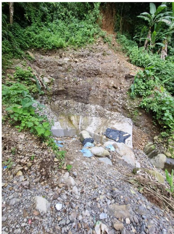
Fotografía 1. Riesgo de deslave en talud arriba de captación Pamolino 2.
