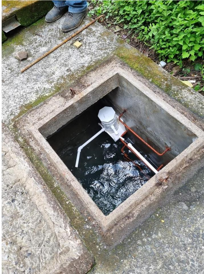
Fotografía 6. Existe un sistema de desinfección, pero aún no se ha conseguido una dosificación adecuada en tanque de sistema Pamolino 3.
