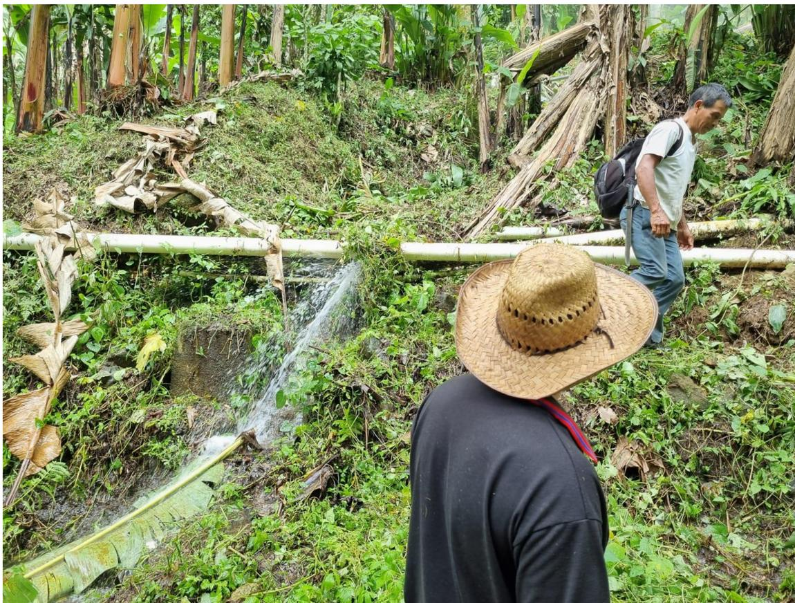
Fotografía 2. Riesgo de rotura de tubería en línea de conducción aledaña a río Ixtacapa.
