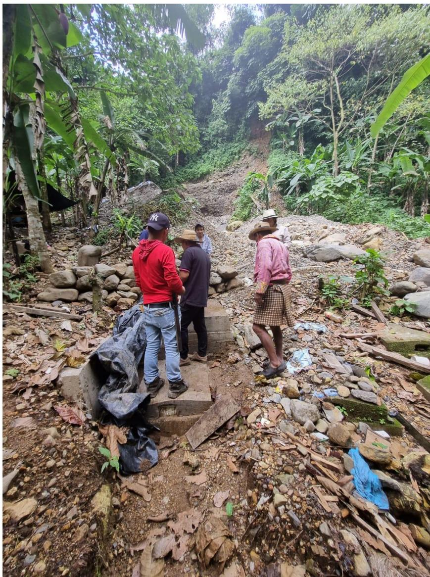
Fotografía 3. Riesgo por contaminación por inundación en caja reunidora de caudales de sistema Pamolino 2, puesto que se encuentra en el paso de escorrentía.
