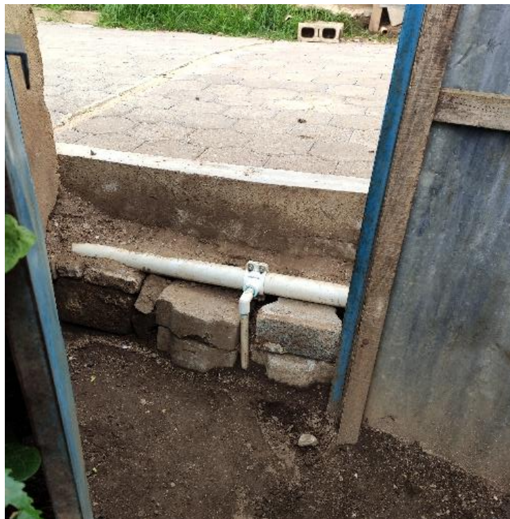
Ilustración 6: Fotografía del riego en la red de distribución
