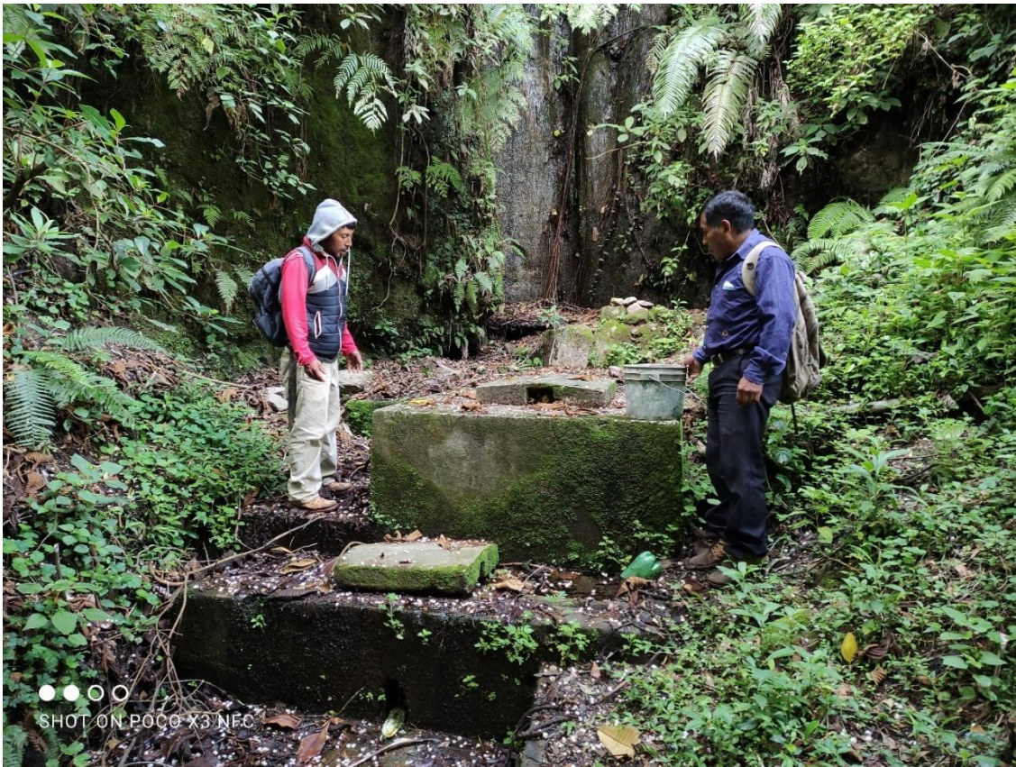
Ilustración 4: Fotografía de la captación del nacimiento
