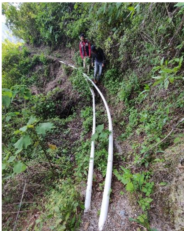
Ilustración 5: Fotografía de riego en la línea de conducción
