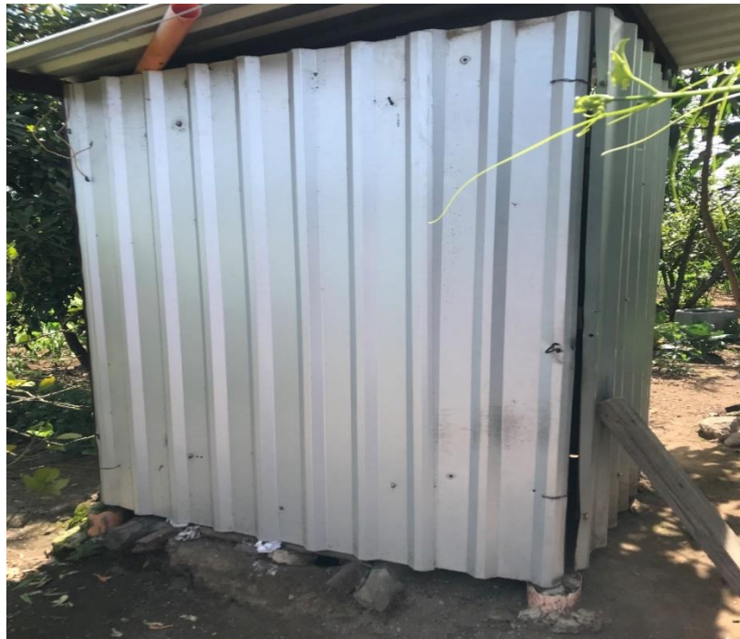
Ilustración 6. Se representa la disposición final de excretas, mediante letrinas de hoyo seco ventilado.
