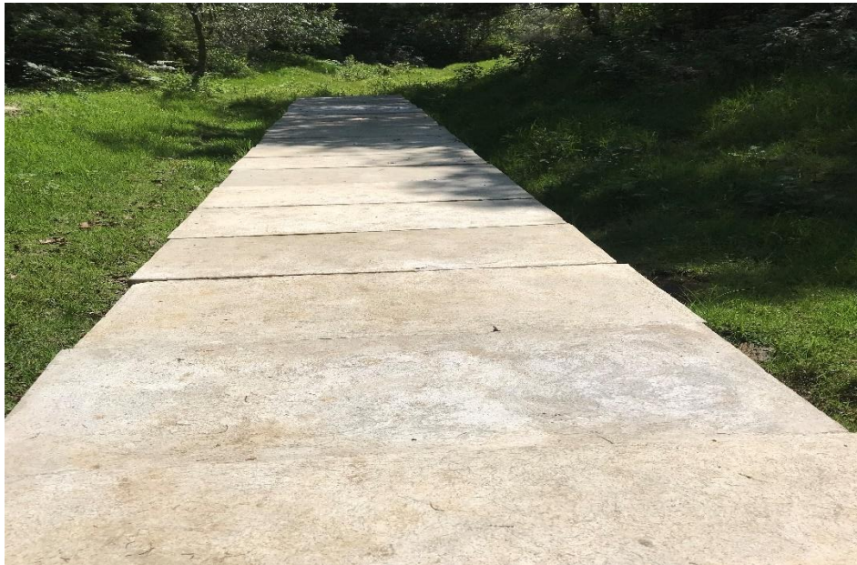
Ilustración 4. Se observa unidad de tratamiento, contando con 12 cajas,
