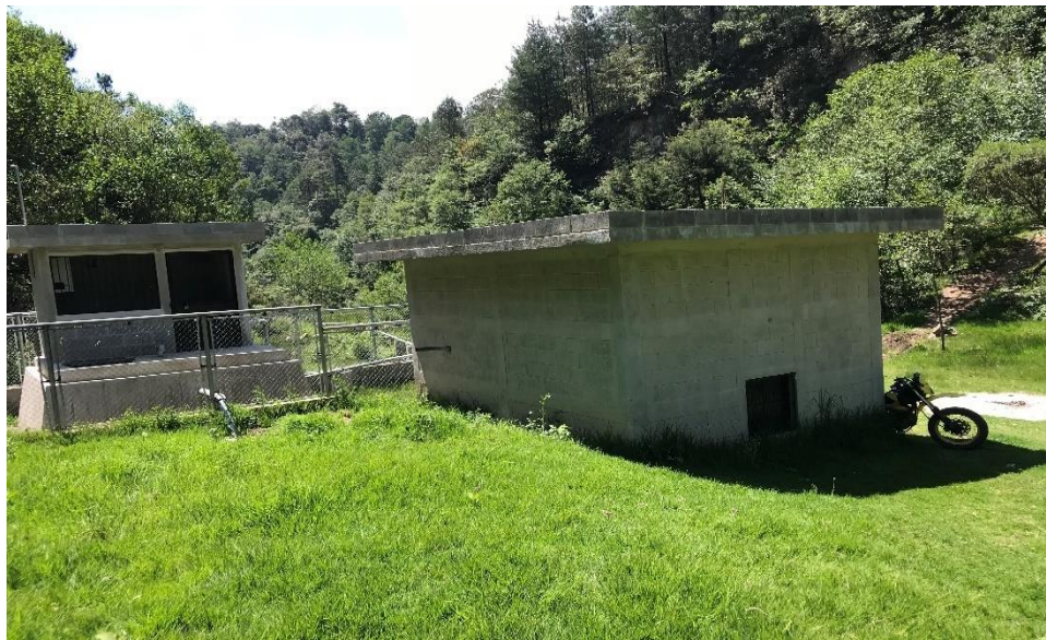
Ilustración 10. Casetas de unidad de bombeo
